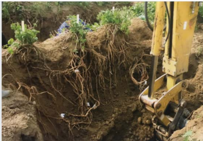
Saaz, 15 years, excavation work Žatecký poloraný červeňák, 15 let, výkopové práce
